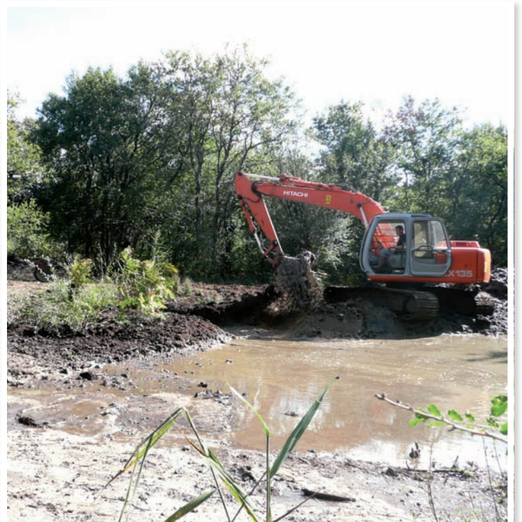
Travaux de restauration de la mare forestière du Grondin © L. Caud, octobre 2012
