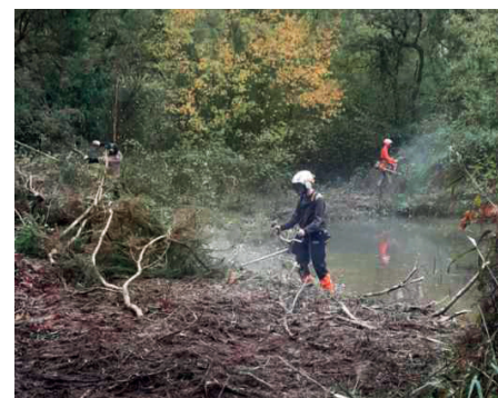
Ouverture du chantier © V. Bernard / ONF
